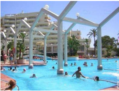
vista de conjunto
