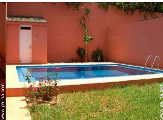
Piscina a desbordamiento
