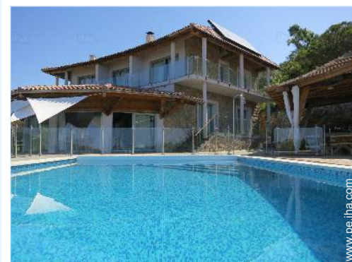
vista de conjunto
