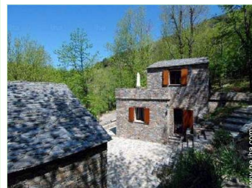
vista de conjunto
