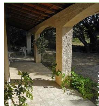
vista desde la terraza cubierta
