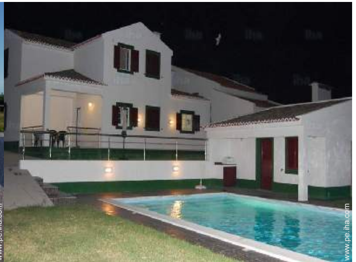
vista de conjunto
