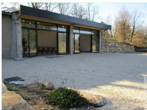
Instalaciones a disposición
